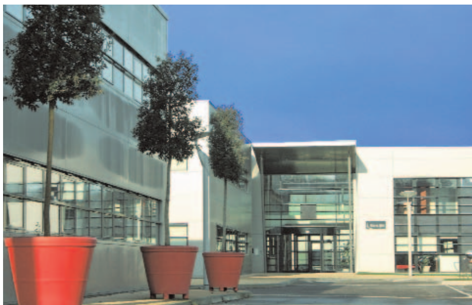
Construction du Siège social de la communauté d’agglomération Tours Plus dans le Business Pôle, quartier des Deux Lions, Tours (37) : façade de l’immeuble.
