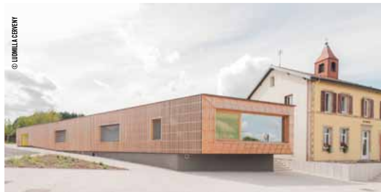
Restructuration de l'école maternelle de Sanchey (88)
